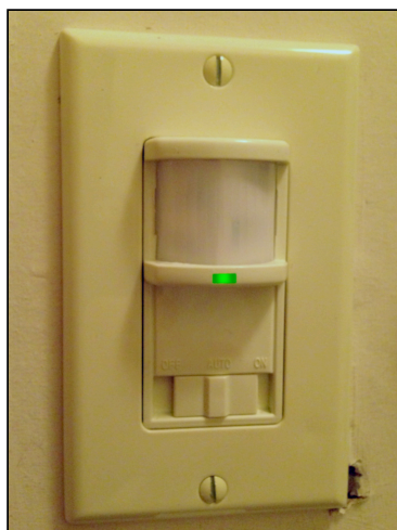
รูปที่ 2.8 สวิตช์ไฟภายในอาคารที่ติดตั้งเซนเซอร์ตรวจจับการครอบครองแบบ PIR
