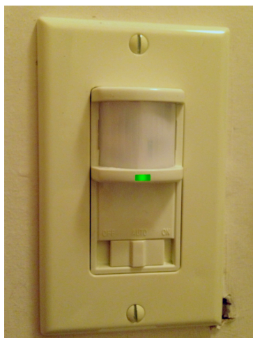
รูปที่ 2.7 สวิตช์ไฟภายในอาคารที่ติดตั้งเซนเซอร์ตรวจจับการครอบครองแบบ PIR
